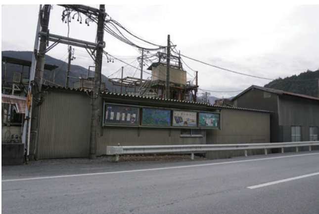
南部小学校付近にある工場の外壁面
